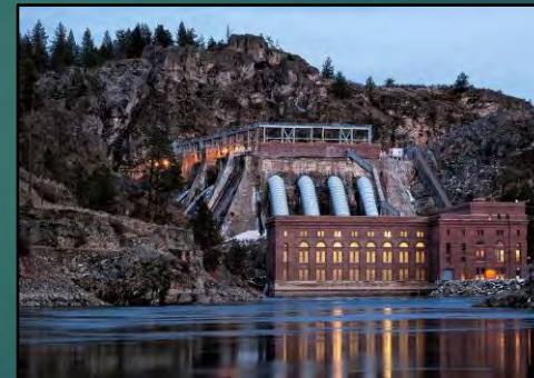
Long Lake Dam, Avista Corp
